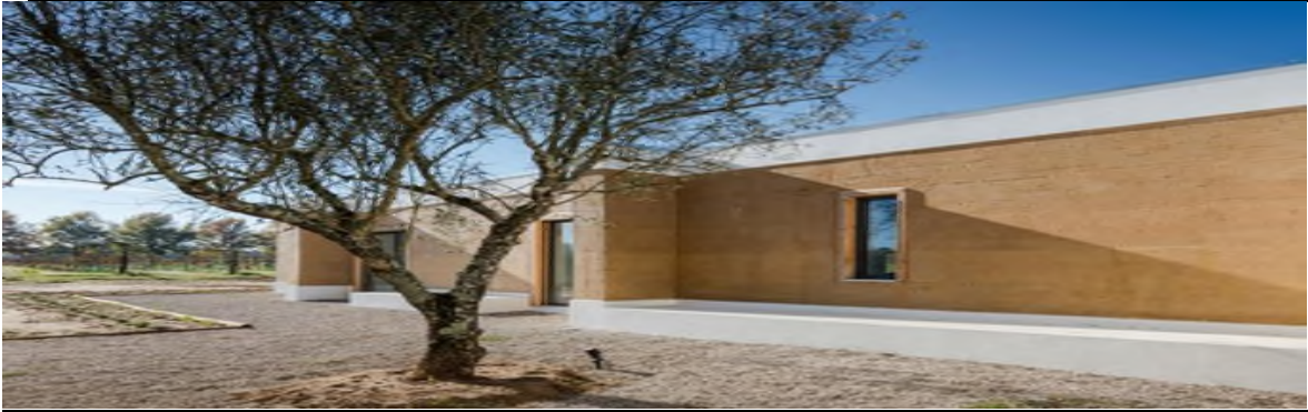
صورة لأحد المباني بتقنية الطوب المثبت-المصدر ERTH CONSTRUCTION
