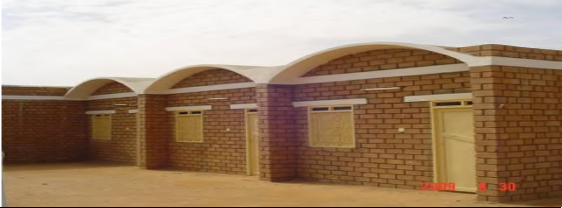
صورة 6 تبين جزء من مباني تم تنفيذها بواسطة الطوب المثبت قليل التكلفة في منطقة بابنوسة المصدر: Blue Nile Organizations Network .
