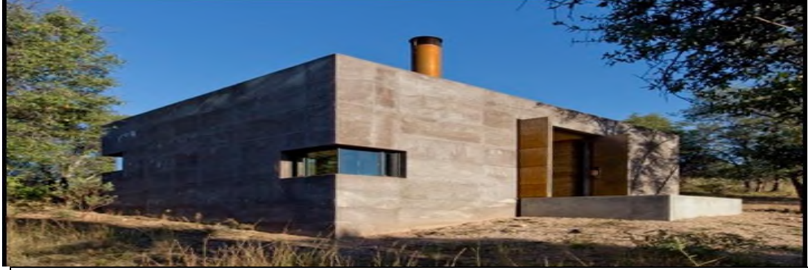
صورة لأحد المباني بتقنية الطوب المثبت-المصدر ERTH CONSTRUCTION
