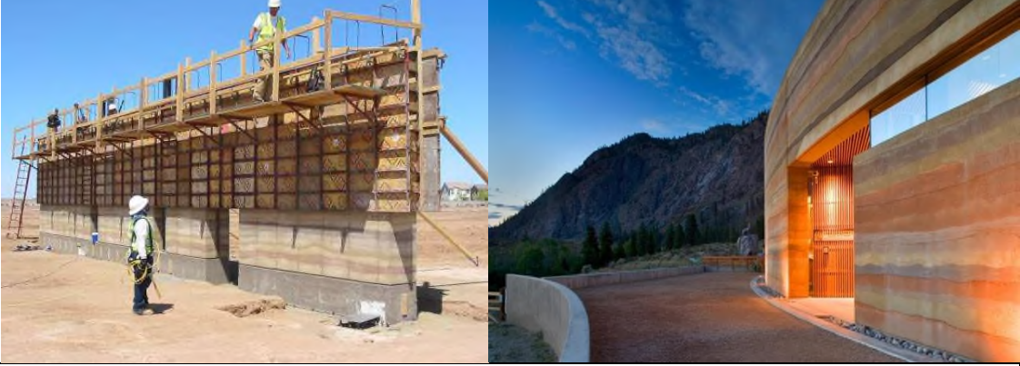
صورة 7-8 تبين تقنية وشكل البناء المدكوك المصدر تقنيات البناء بالمواد الطبيعية
