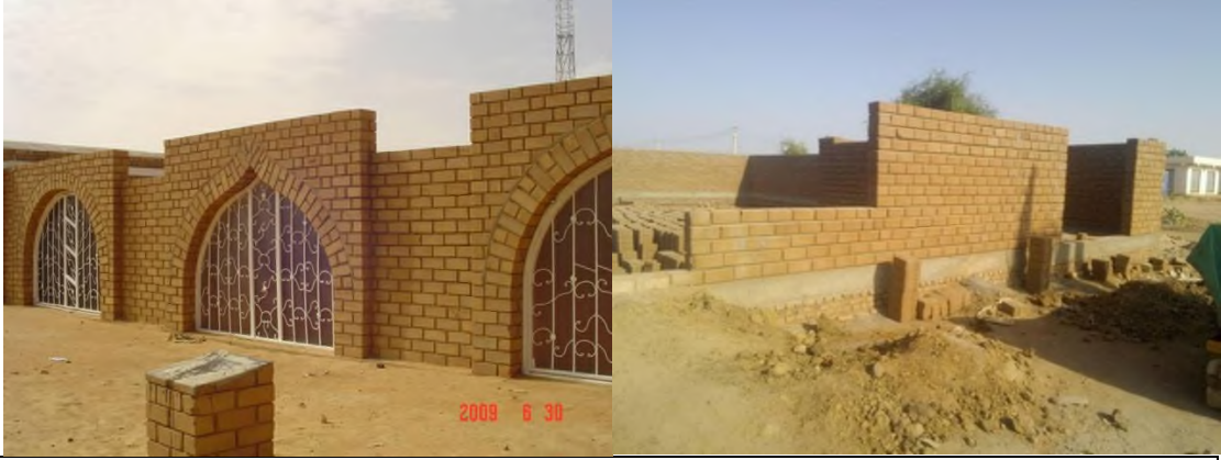
صورة 5 تبين جزء من المباني التي تم عملها بالطوب المثبت قليل التكلفة بحي الدمازين شمال علي الطريق القومي المصدر: Blue Nile Organizations Network
